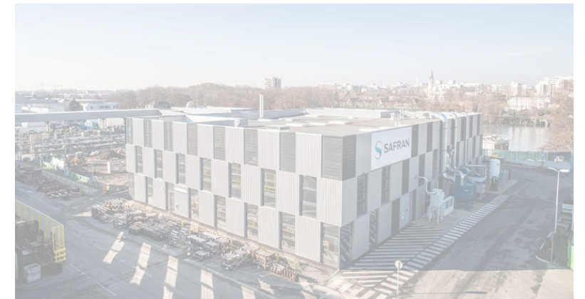
Site de Safran PFX, plateforme de recherche sur les aubes du futur (Gennevilliers) [Safran, 2019]
